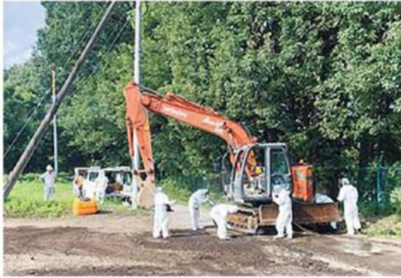
重機の洗浄（26日撮影）
