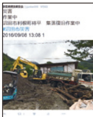
H28.9月 台風13号による集落復旧作業(沼田市)
