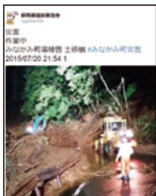
H27.7月 集中豪雨による土砂崩れ災害(みなかみ町)
