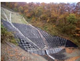
復旧治山工事
