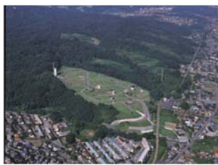
住宅団地造成工事
