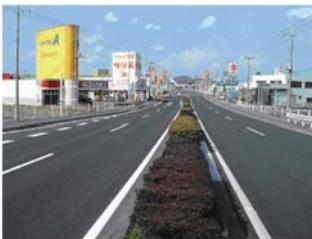
道路舗装工事
