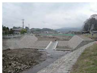
河川床固工事
