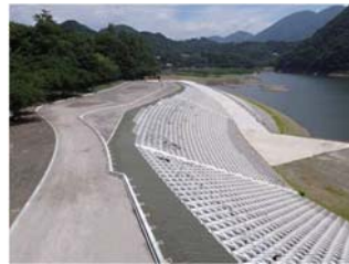
ダム湖岸環境整備工事
