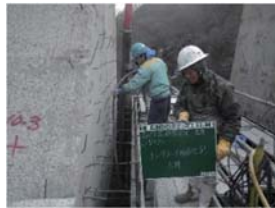
腹付コンクリート打設状況
