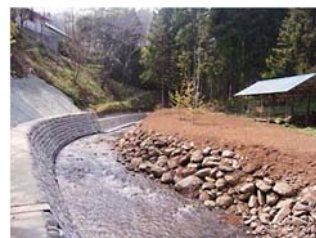
河川災害復旧工事
