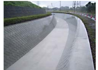
火山砂防工事
