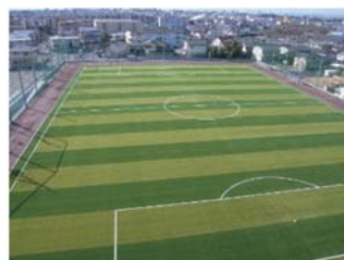
グラウンド整備工事
