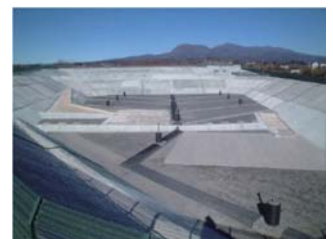
環境衛生(最終処分場)工事
